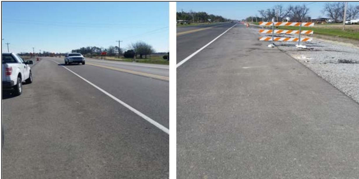
Figure A.29 STA 991 + 00
