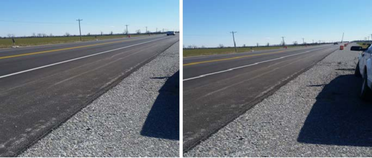
Figure A.15 STA 826+00
