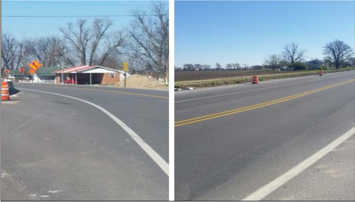
Figure A.30 STA 732 + 00
