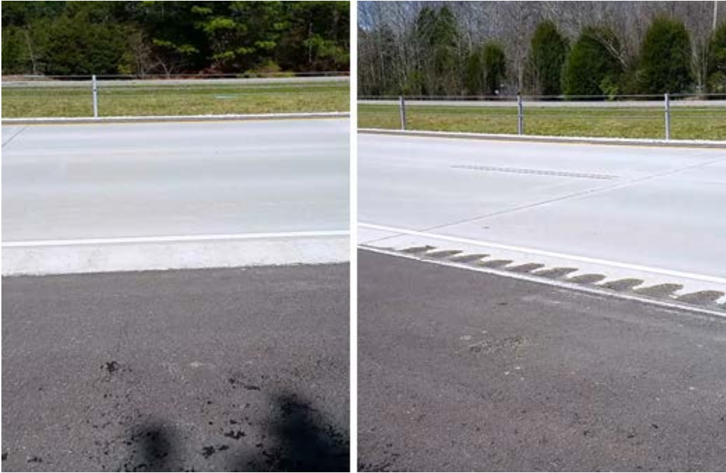
Figure A.5 STA 2007+50
