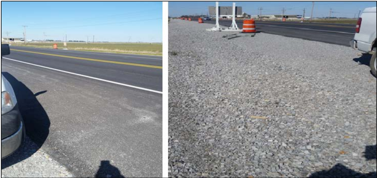
Figure A.24 STA 753+ 00
