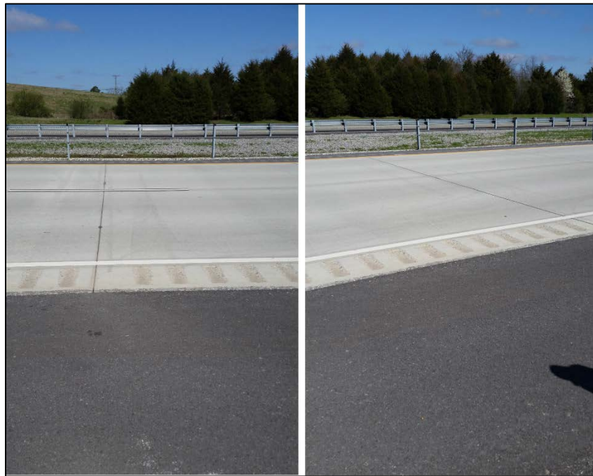
Figure A.2 STA 1946+00
