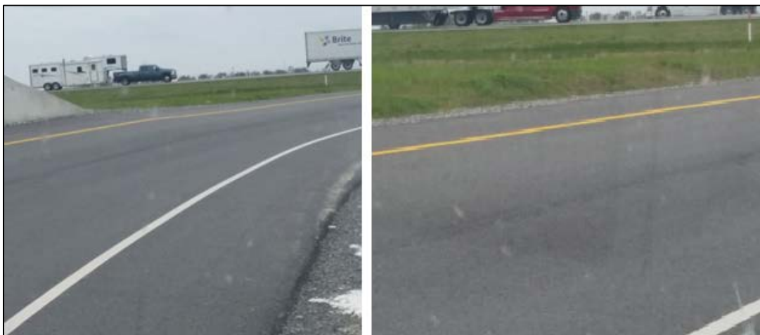
Figure A.12 STA 481 + 00
