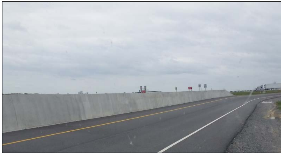
Figure A.11 STA 480 + 00
