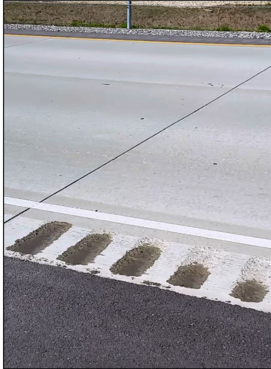
Figure A.7 STA 2145+00
