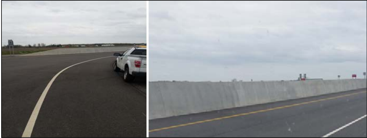
Figure A.10 STA 478 + 50
