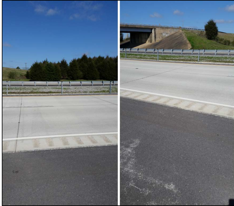
Figure A.1 STA 1950 + 00
