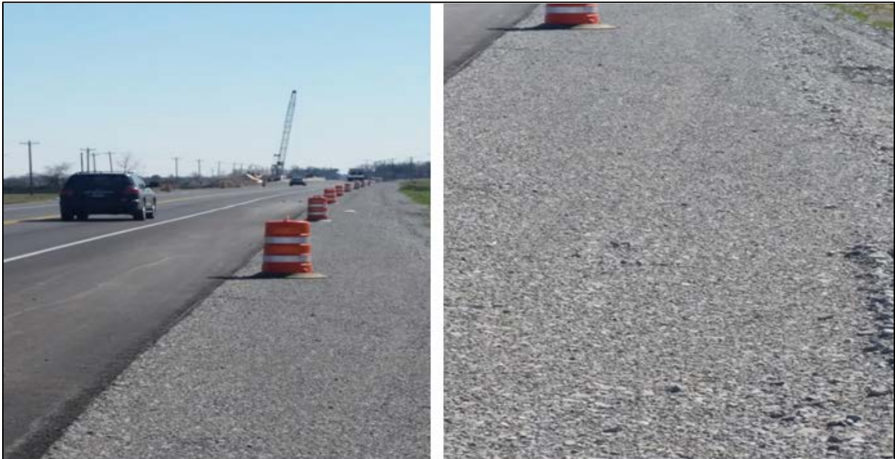
Figure A.14 STA 832 + 50
