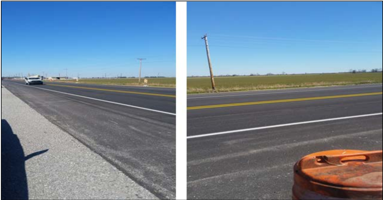
Figure A.16 STA 819 + 50
