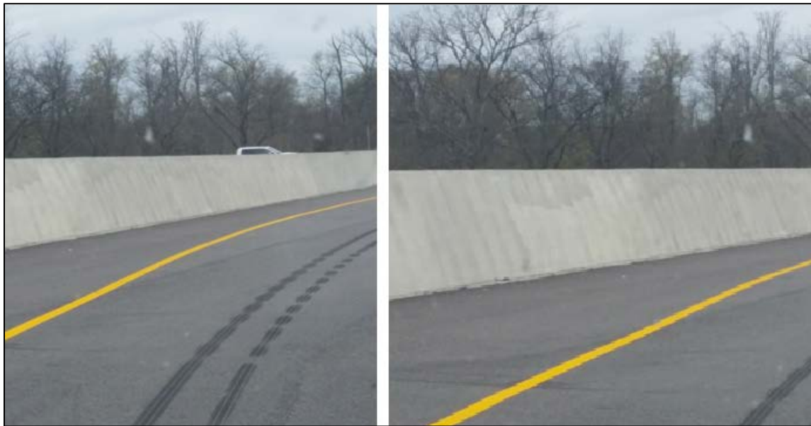
Figure A.9 STA 475 + 25
