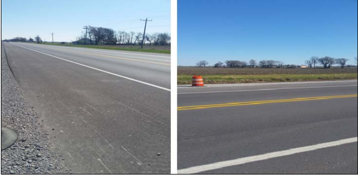
Figure A.23 STA 742 + 60
