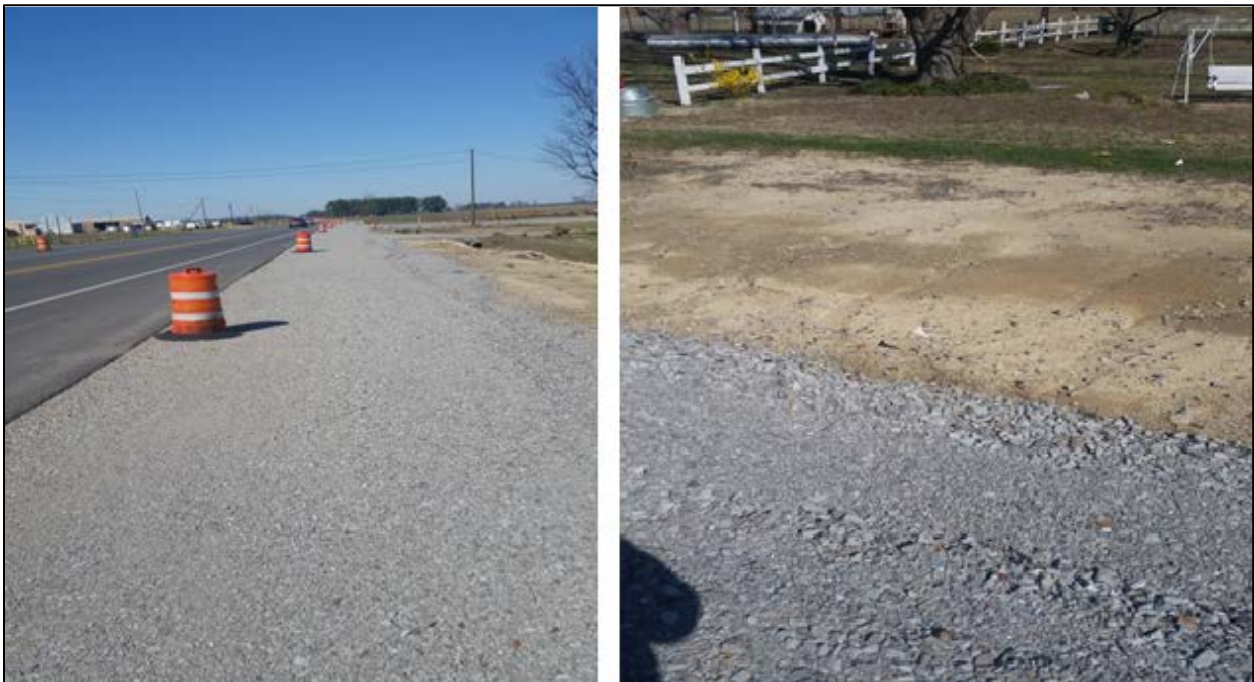
Figure A.26 STA 727 + 00
