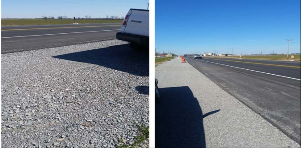
Figure A.13 STA 815 + 00
