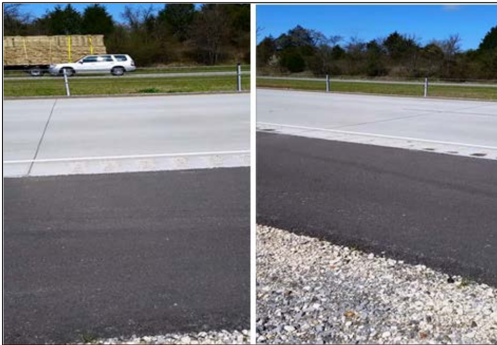
Figure A.6 STA 1972+00
