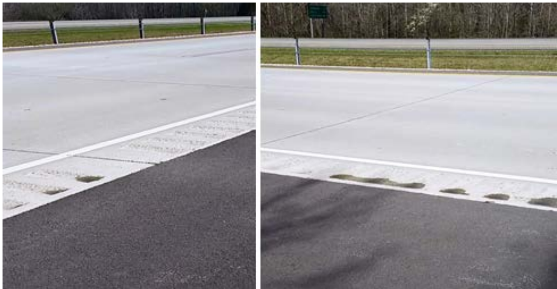
Figure A.4 STA 2059+50
